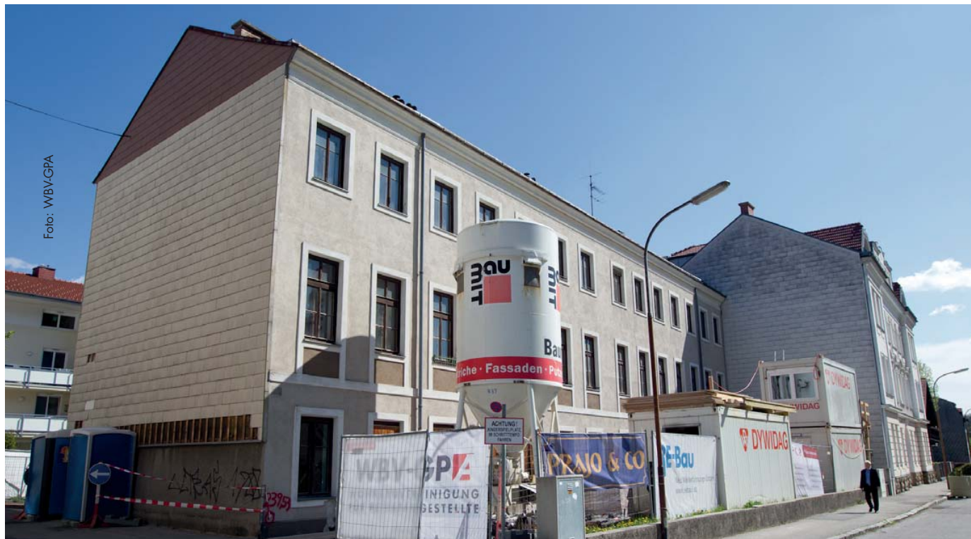
Bald erstrahlt das Wohnhaus in der Wienzeile 6a in Purkersdorf in neuem Glanz.
