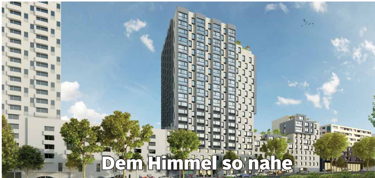
Der Wohnturm MySky an der Laaer-Berg-Straße in Wien Favoriten erfüllt so ziemlich jeden Wohnwunsch.
