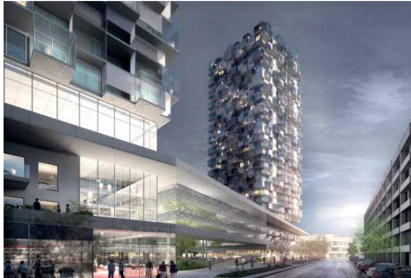
Der dreigeschoßige Sockel beherbergt im untersten Geschöß Nahversorgung und günstige Geschäftsflächen für innovative Start-up-Unternehmen.
